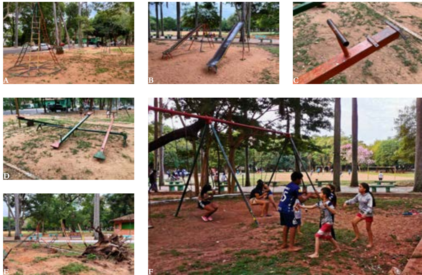
Fig.A. Torres metálicas para trepar. Fig.B. Toboganes herrumbrosos y rotos. Peligro de corte para los niños. Fig.C y D. Toboganes con falta de mantenimiento, carencia de piezas y elementos punzantes peligrosos. Fig.F. Niños jugando en el sector de hamacas.
