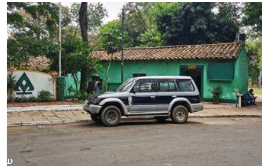
Fig. A. Vivero Fig. B. Depósito y baños Fig. C. Camión recolector de. Depto. de Servicios Urbanos. Fig. D. Oficina de Áreas Verdes
