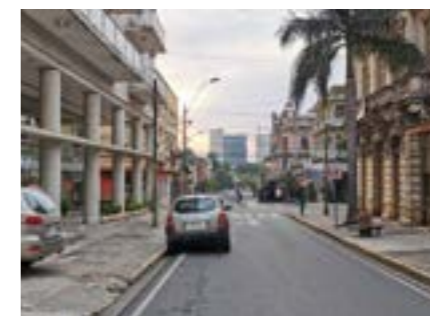
Izquierda Hotel Armele, a la derecha edificio Patrimonial. Calle Palma
